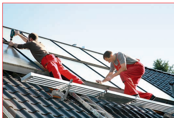
Die Modernisierung der bestehenden Heizungsanlage ist oft günstiger als der Wechsel auf einen anderen Energieträger.
